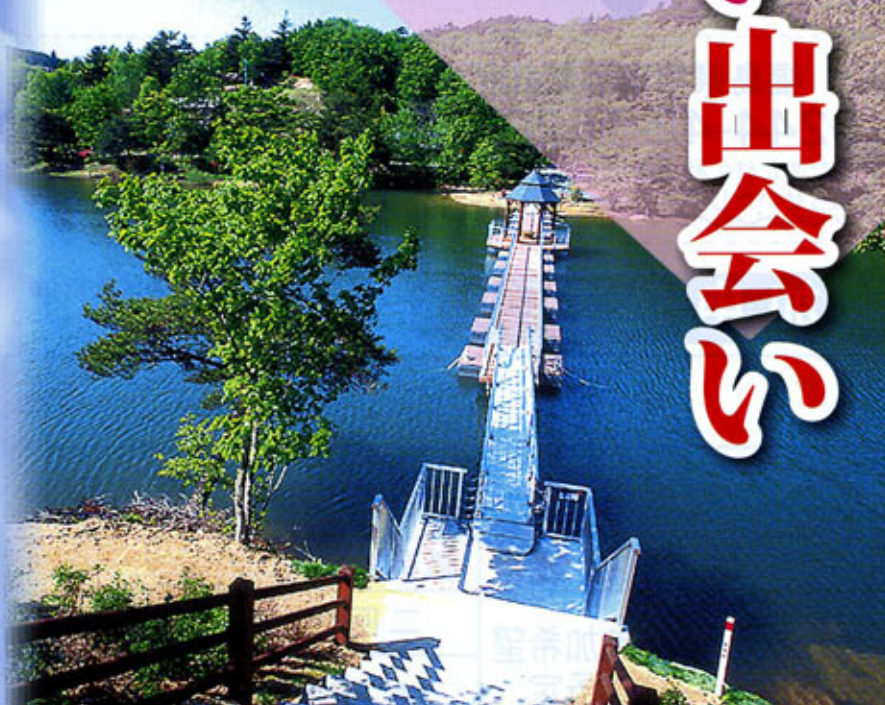
あいの沢「あいの浮橋」
